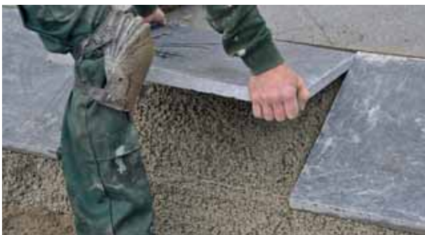
3. De tegel in de drainagemortel leggen | Poser la dalle sur le mortier drainant | Die Platte in den Drainagemörtel legen | Lay the tile in the drainage mortar
