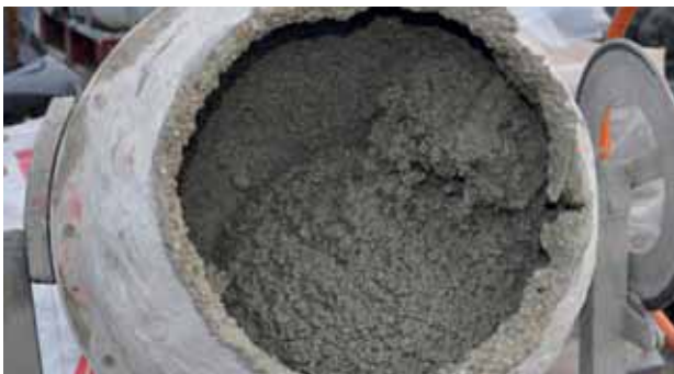
1. Het aanmaken van drainagemortel | Faire du mortier drainant | Den Drainagemörtel anmischen | Prepare the drainage mortar
