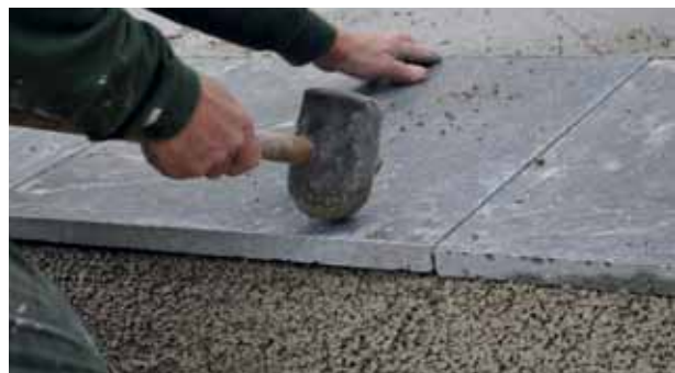
4. De tegel in de nog niet uitgeharde drainagemortel aanbrengen | Taper la dalle au maillet dans le mortier | Die Platte soll in den noch nicht ausgehärteten Drainagemörtel gelegt werden | The tile must be placed on the drainage mortar before it has hardened
