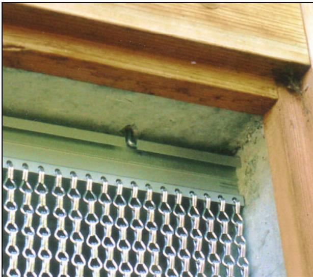
An Winkelschrauben aufgehängtes Profil
