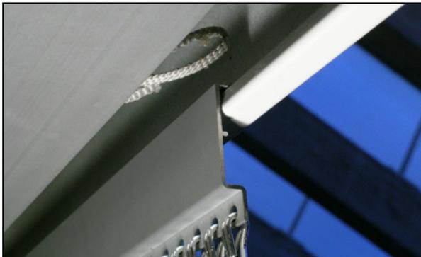
Eingehängtes Profil in Storenkastenblende
