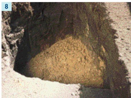
Es folgt die Anpassung der Grube mit Füllsand auf den unterschiedlich ausgehobenen Stufen.
