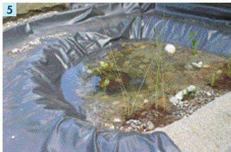
5 Kieselsteine und Pflanzen werden eingebracht und der Teich mit Wasser befüllt. Nach dem Einlassen des Wassers muss sich die Folie zunächst vollständig setzen, bevor mit der Randbefestigung begonnen werden kann.
