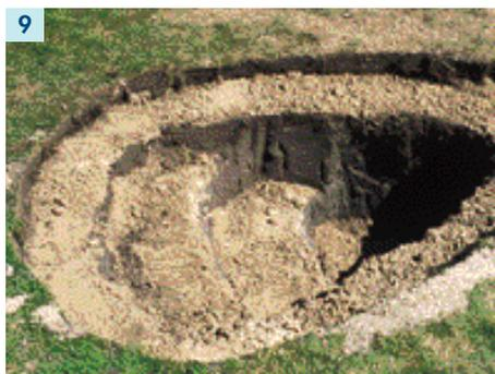
So sieht der fertige Aushub für die Teichschale inkl. der Füllsandschichten aus.
