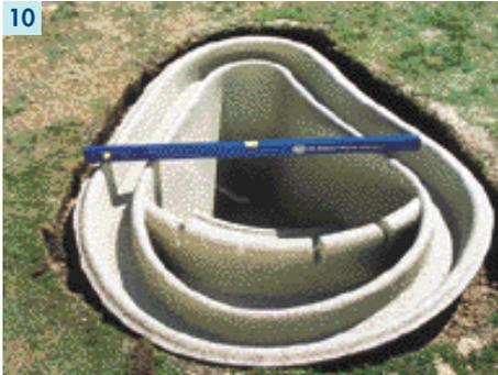
10 Das Becken wird eingesetzt und in Länge und Breite ausnivelliert.
