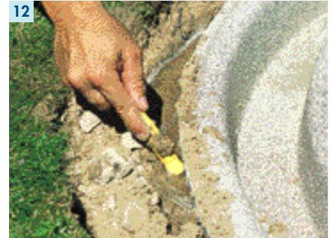
12 Ringsherum wird Sand mit dem Gartenschlauch unter den Rand der Teichschale geschlämmt, um bestehende Hohlräume auszufüllen.
