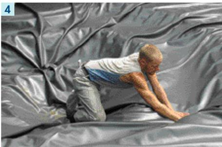
4 Nach dem Auskleiden der Teichmulde mit Vlies, zum Schutz gegen spitze Steine und Wurzeln, wird die Folie verlegt.
