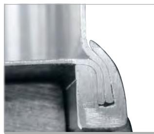
**6 Rand-, Boden-, Deckelprofilrahmen** aus Vollprofilen, Stoß vollverschweißt mit Blech durch hochfesten Formschluss dauerhaft verbunden.
