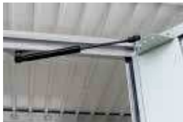
▲ Gasdruckfeder: hilft beim Öffnen und Schliessen des Türflügels. Sie hält den Türflügel in geöffneter und in geschlossener Position.
