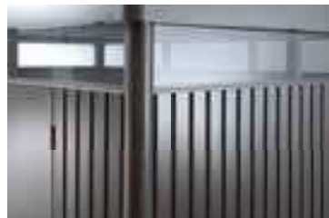
▲ Acrylglas-Oberlichte: Das umlaufende Acrylglas-Lichtband bietet eine gute Lichtdurchflutung.
