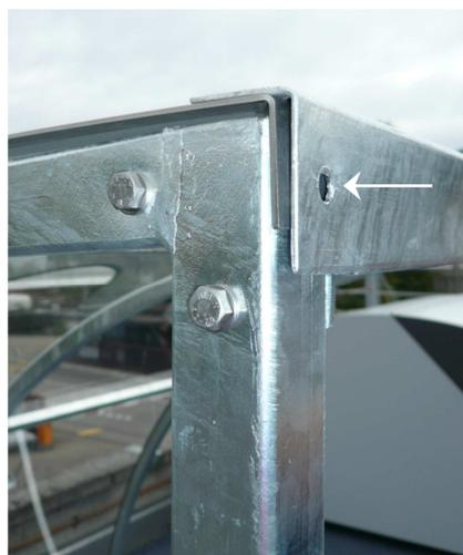
Die Inox-Spannbänder runterdrücken und das U-Profil von vorne her darüberschieben. Mit 3 Schrauben alles befestigen.
