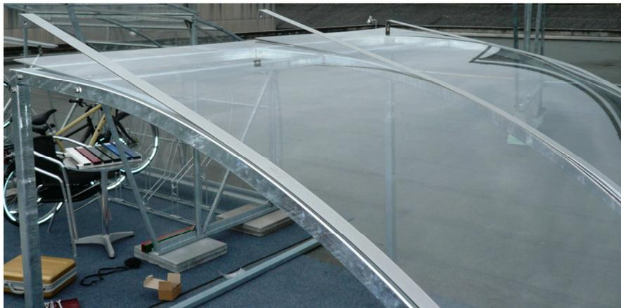
Die 3 Inox-Spannbänder auf die Acrylgläser auflegen, so dass die kleine Gewindestange hinten in die Lasche eingeführt werden kann. Die Mutter anbringen aber noch nicht festziehen.
