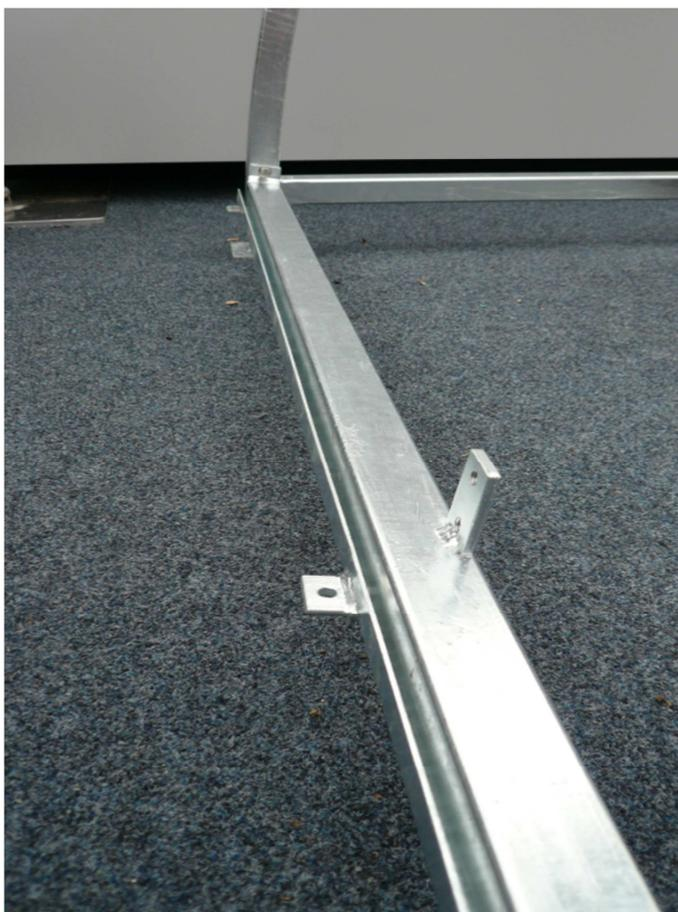
Die vormontierte Horizontalstrebe an beiden Seitenrahmen befestigen.
