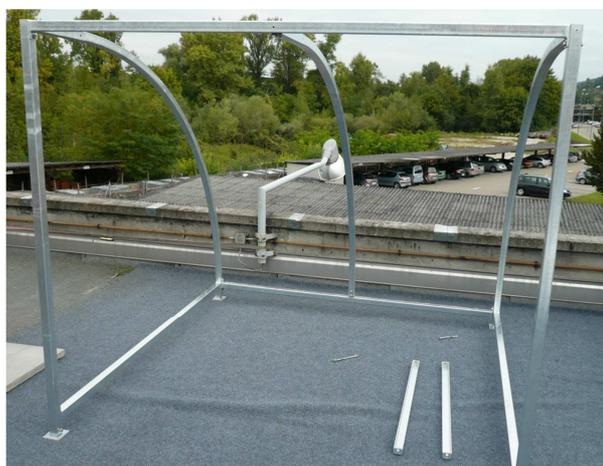
Die Mittlere Bogenstange auf die untere Horizontalstrebe in der Mitte aufsetzen.
