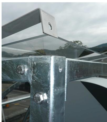
Die Spannbänder müssen so aufliegen damit diese an der oberen Horizontalstrebe resp. am U-Profil befestigt werden können.
