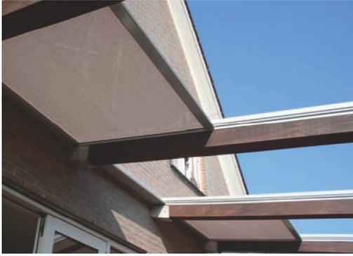
VENTOSOL – dieser Name steht für moderne und solide Fassadenbeschattung mit grossem Einsatzbereich. Dank dem SIR-System (Soft Integrated Retaining System), welches wie ein Reissverschluss funktioniert, wird eine maximale Stabilität der innenliegenden Tuchführung gewährleistet. VENTOSOL-Markisen halten somit Windgeschwindigkeiten von 75 bis 120 km/h (abhängig von Dimension und Montagesituation) stand.
