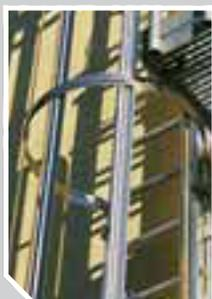
Ein- und mehrzügige Steigleitern mit Absturzsicherung durch Rücken- bzw. Steigschutz
